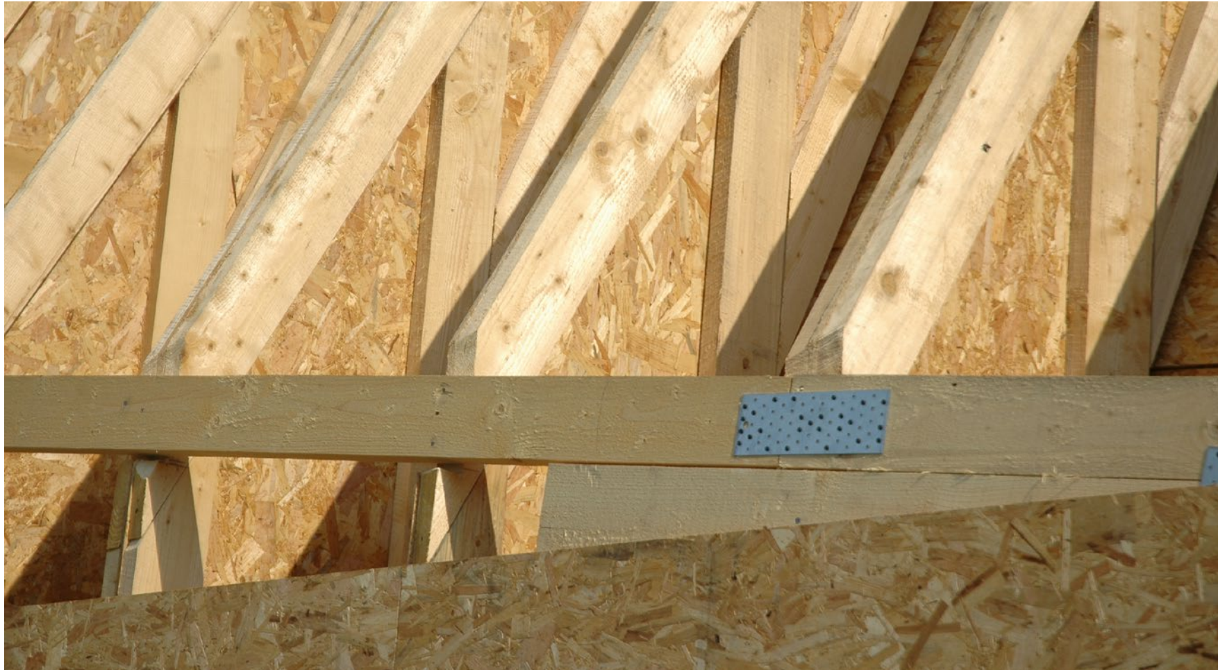
A pavilonok építése 2015 augusztusában fotó: Vasáros Zsolt
