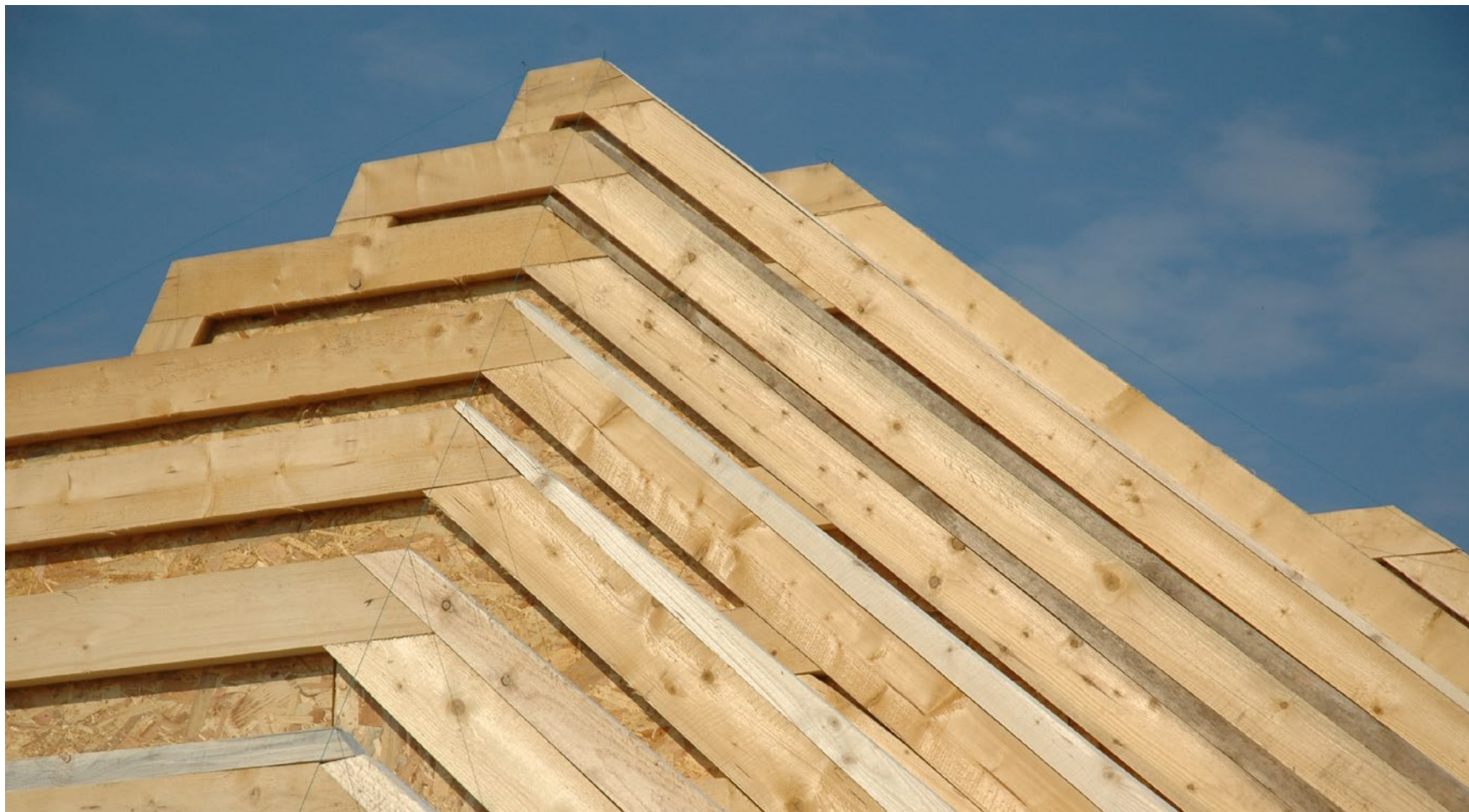
A pavilonok építése 2015. augusztusában fotó: Vasáros Zsolt
