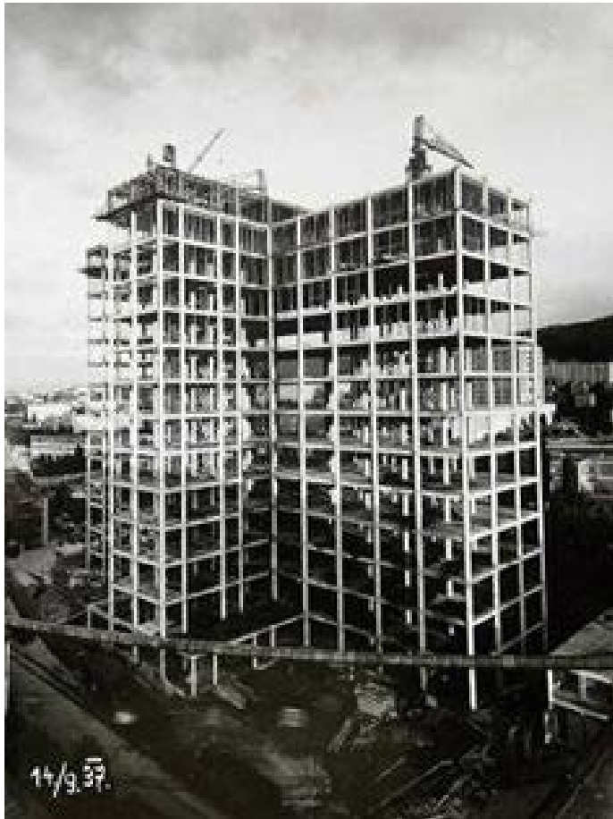
Bat'a "csontváz" szerkezetű felhőkarcoló építése
