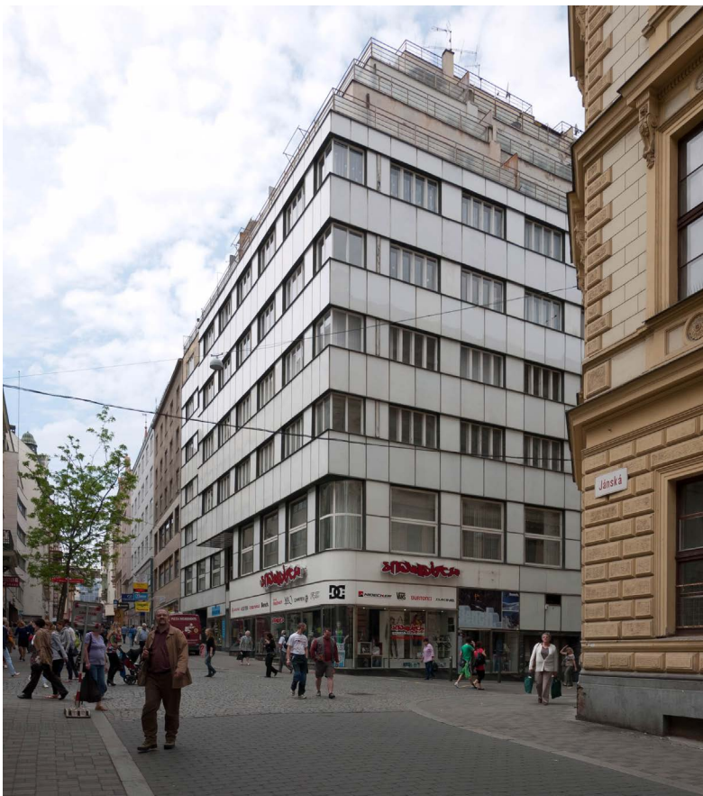
Alfa irodaház - 1937, Brno
